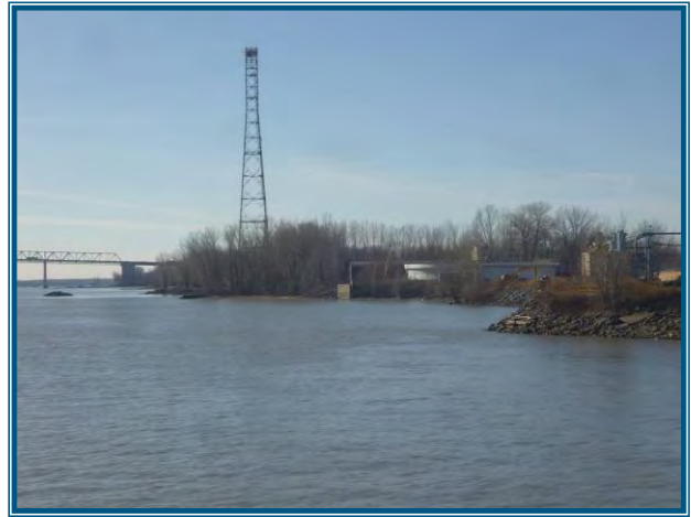
Photo 4 : Vue du secteur amont du site du projet.
