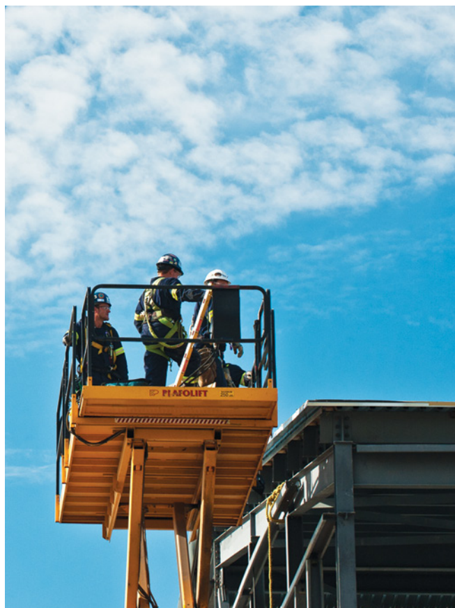
Des travailleurs s'affairent à la construction d'un édifice sur le site de Niobec.
