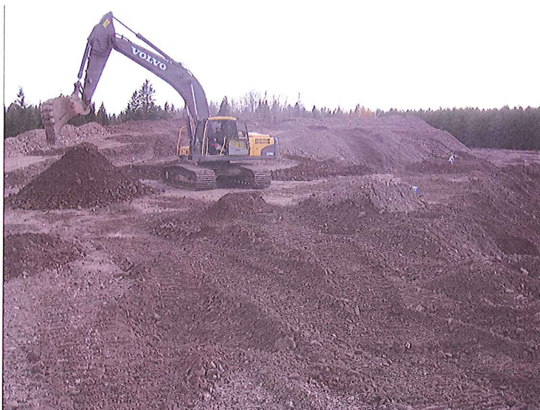
Photo no 4: Prélèvement à l'aide d'une pelle excavatrice dans l'halde de minerai, vue vers l'ouest.
